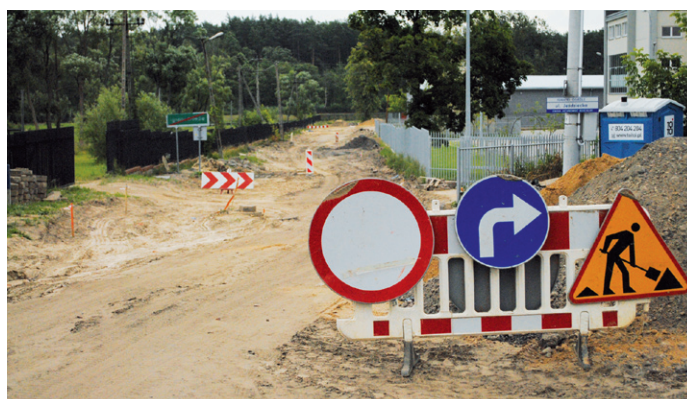
Budowa ciągu dróg w Ignatkach-Osiedlu
