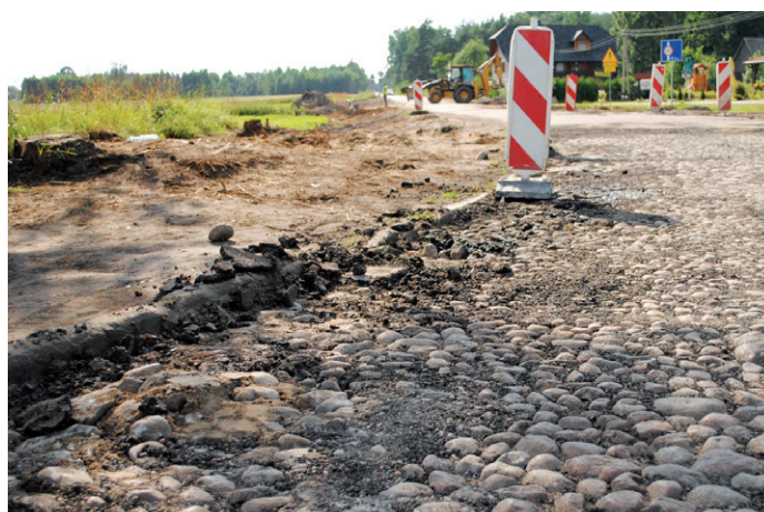
Przebudowa drogi Juchnowiec Kościelny-Wojszki do drogi S19
