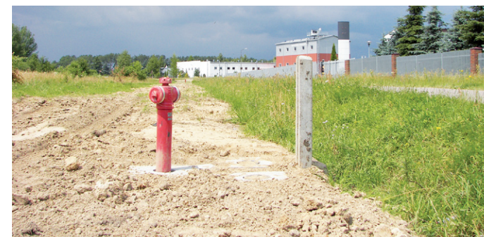
Budowa wodociągu w Ignatkach
