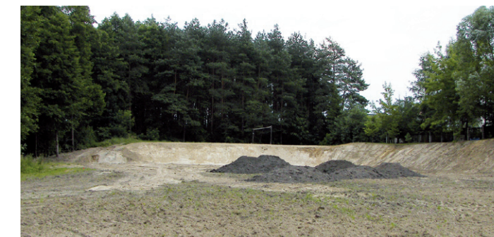
Budowa boiska w Olmontach
