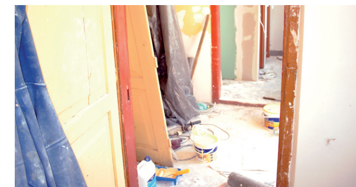
Remont świetlicy wiejskiej w Hołówkach Dużych
